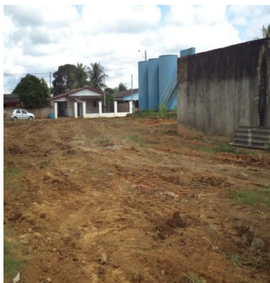
Foto 16: unidade de tratamento e área de reservação.
