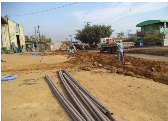
Foto 02: escavação e assentamento de tubulação de 50mm de PVC - PBA no trecho da Avenida Ayrton Senna.
