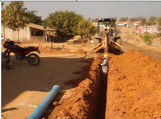
Foto 05: escavação e assentamento de tubulação de 150mm de FoFo para rede de distribuição no trecho da Avenida Porto Velho.
