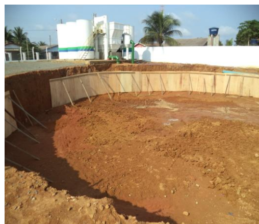
Foto 23: vista geral da nova área de reseqüência com capacidade de 2000m³ em construção.
