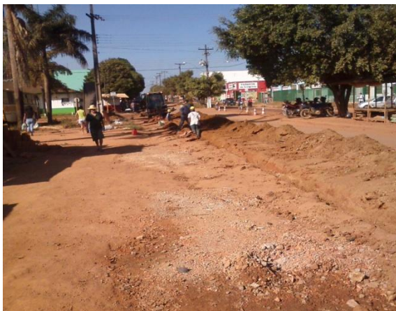
Foto 06: Avenida Porto Velho assentamento de distribuição, tubulação de 50mm de PVC - PBA.
