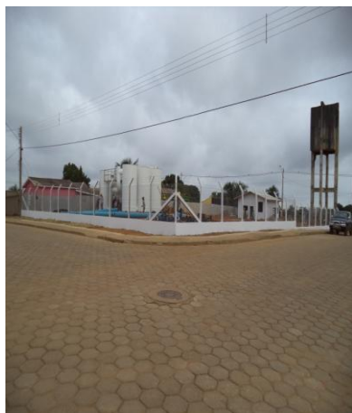
Foto 20: vista geral da estação.
