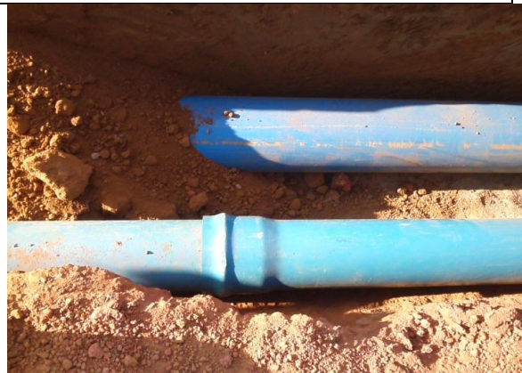
Foto 07: Avenida Monte Negro escavação e assentamento de adutora de 400mm de FoFo e rede de distribuição de 300mm de FoFo.
