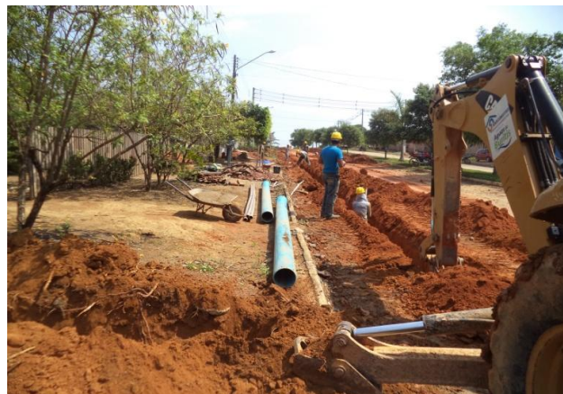
Foto 08: Avenida Paraná escavação e assentamento de tubulação de 200mm de FoFo e 50mm de PVC - PBA ambos para rede de distribuição.
