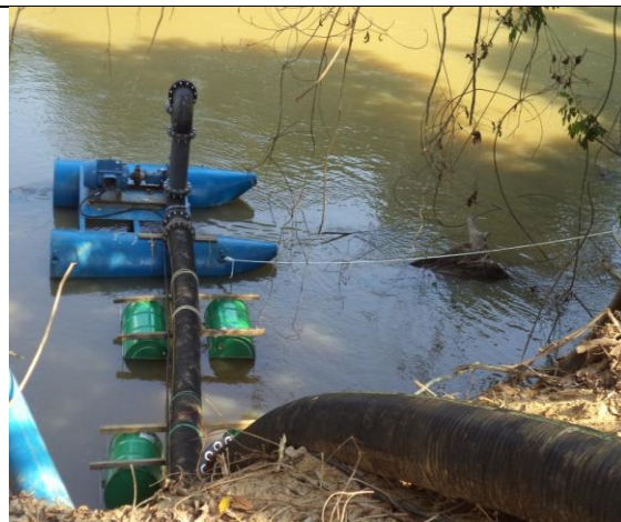
Foto 15: assentamento da balsa juntamente com a moto bomba.
