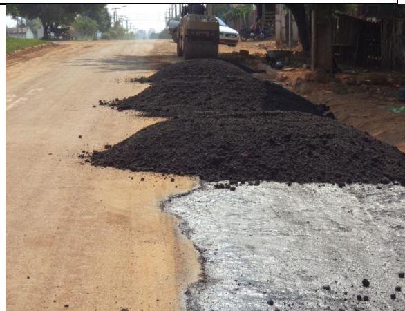
Foto 10: imprimação e assentamento de massa asfáltica em ruas e algumas avenidas.
