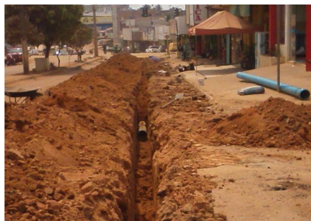
Foto 04: escavação e assentamento de tubulação de 200mm de FoFo no trecho da Avenida Porto Velho.
