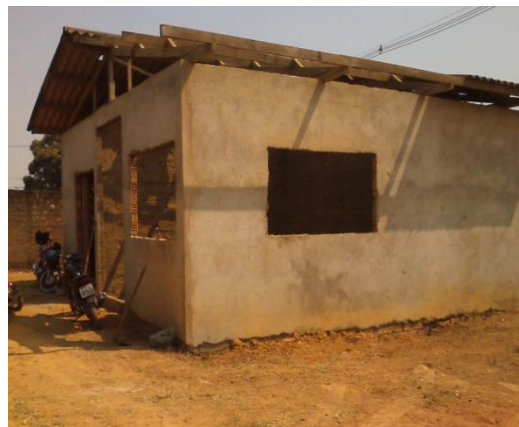
Foto 19: casa de química com compartimento da casa de bomba, laboratório e compartimento dos tanques de dosagem.
