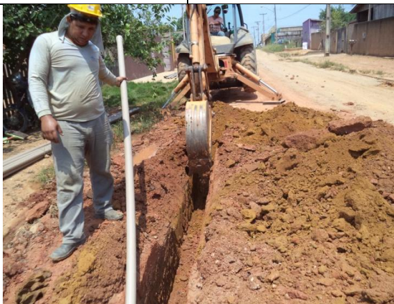
Foto 09: escavação e assentamento de tubulação de 50mm de PVC – PBA nas ruas principais.
