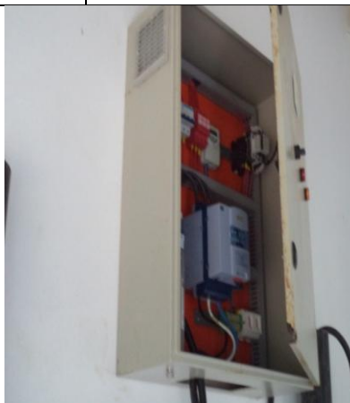
Foto 13: montagem do painel na casa de comando.
