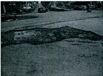
Foto 04: base com CM 30 sem massa asfáltica.
