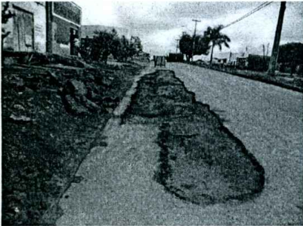
Foto 05: base com CM 30 sem massa asfáltica.
