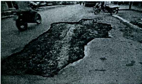
Foto 01: base com CM 30 sem massa asfáltica
