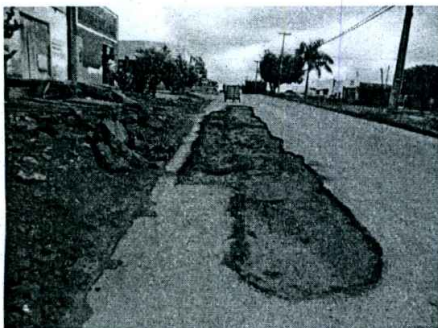
Foto 05: base com CM 30 sem massa asfáltica.
