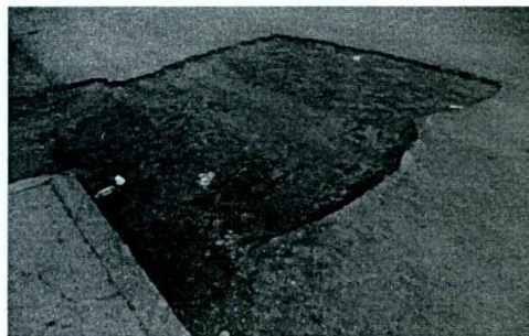
Foto 03: base com CM 30 sem massa asfáltica.
