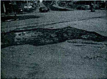
Foto 04: base com CM 30 sem massa asfáltica.
