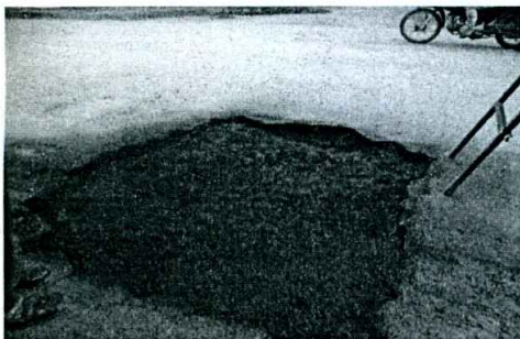
Foto 02: base com CM 30 sem massa asfáltica.
