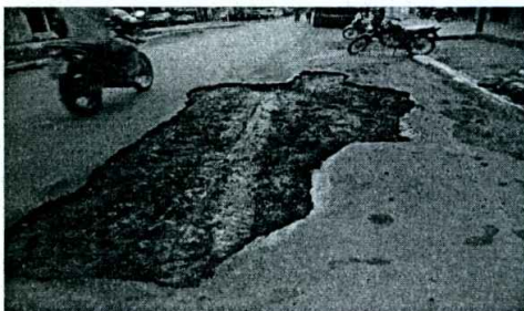
Foto 01: base com CM 30 sem massa asfáltica
