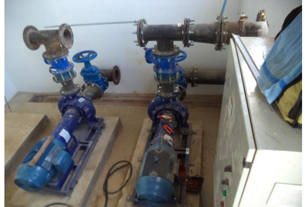
Foto 04: montagem das bombas de pressão no compartimento de bombas.
