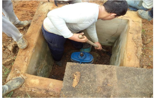
Foto 02: reparo das caixas da descarga evitando rompimento das bolsas.
