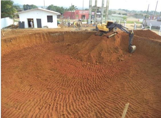
Foto 01: escavação da área de reservação.
