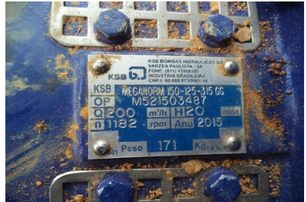
Foto 03: bomba de 40 cv.
