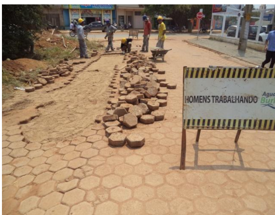
Foto 02: reassentamento dos bloquetes na Rua Cujubim.
