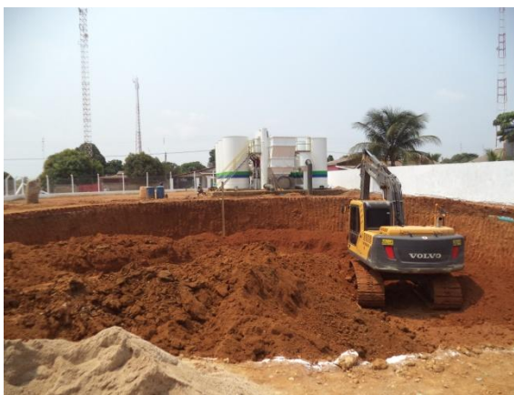
Foto 01: escavação da nova área de reservação de 2 milhões de litros.
