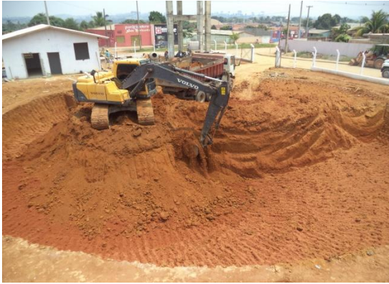
Foto 01: escavação da área reservação.
