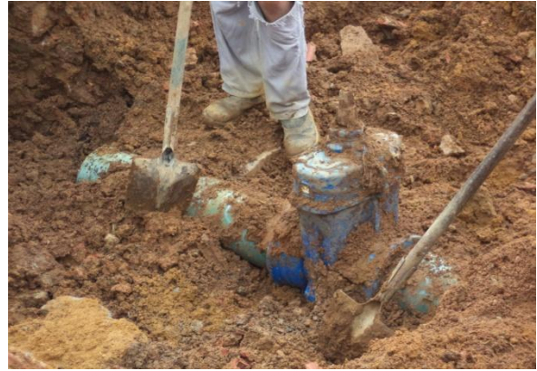
Foto 02: descarga soterrada da adutora e tubulação removida.
