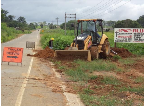
Foto 01: escavação as margens da RO 640.
