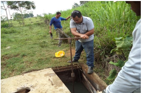
Foto 03: reparo da descarga.
