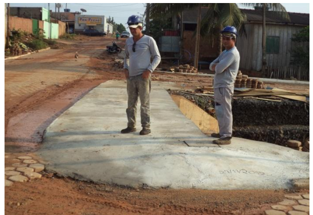
Foto 05: envelopamento e calçamento sobre a passarela no canal da cidadania.
