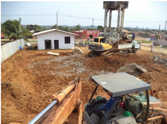
Foto 02: retirada de entulho.
