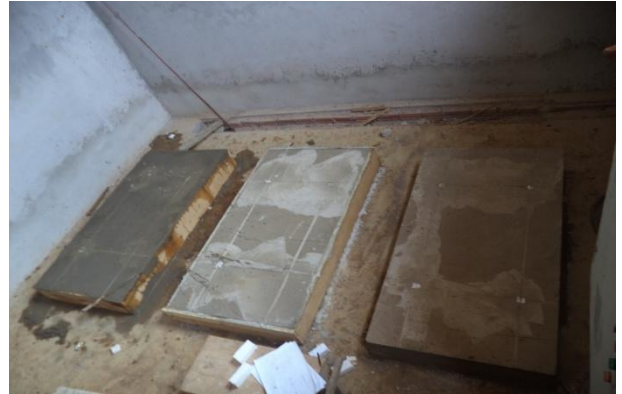
Foto 04: preparação da base para montagem das bombas de Pressurização de 25 cv.
