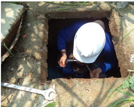
Foto 01: reparo da ventosa.
