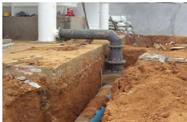
Foto 04: conexão da unidade de tratamento com adutora.
