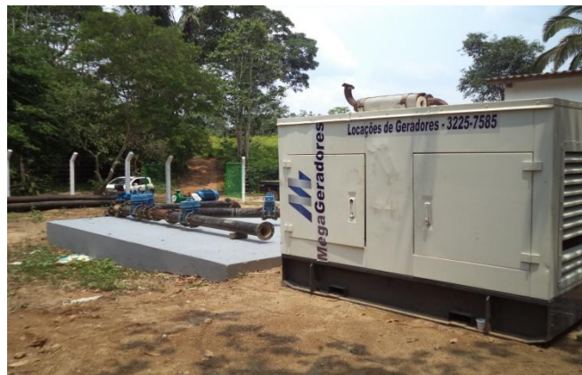
Foto 03: captação, assentamento de geradores e ajuste de mangóte para adutora.
