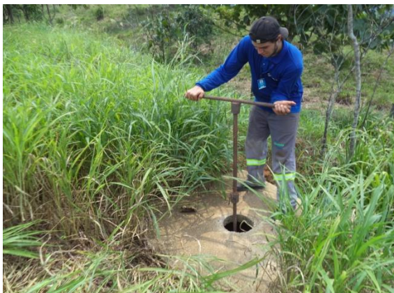
Foto 02: reparo da descarga.
