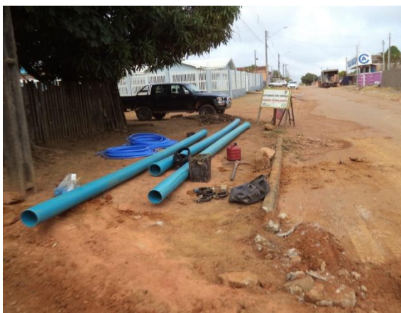
Foto 01: assentamento de tubulações de 150mm de FoFo na Rua Alto Paraíso.
