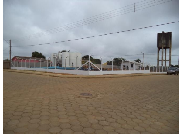
Foto 03: ETA – atividades de recuperação.
