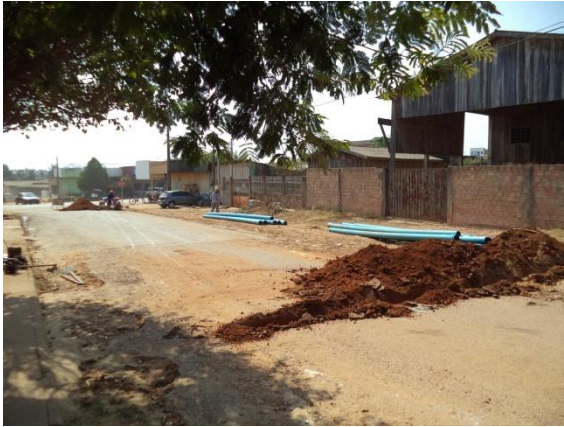
Foto 01: assentamento de tubulações de 150mm de FoFo na Rua Alto Paraíso.
