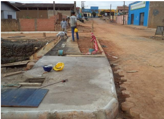
Foto 02: envolvimento da adutora sobre a passarela e calçamento.
