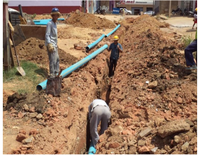
Foto 04: assentamento de tubos de 150mm de FoFo.
