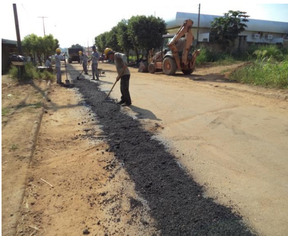
Foto 03: imprimação e assentamento asfáltico na Rua Jose Carlos da Mata.
