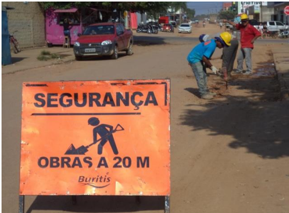
Foto 02: preparação da base para imprimação na Rua Helenita Ferreira de Souza.
