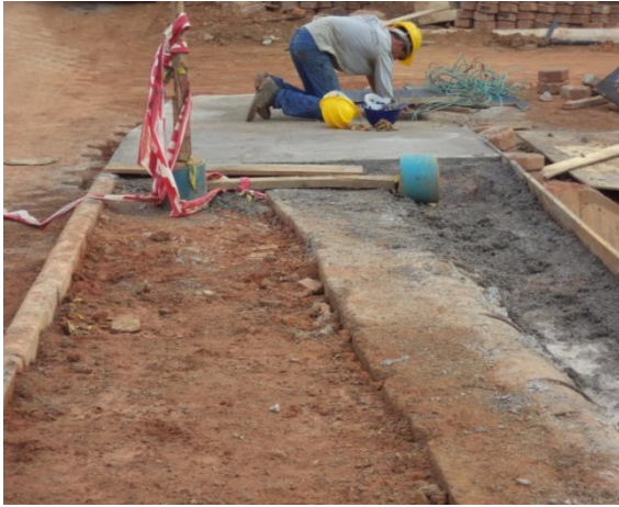
Foto 01: envelopamento e da adutora e calçamento.
