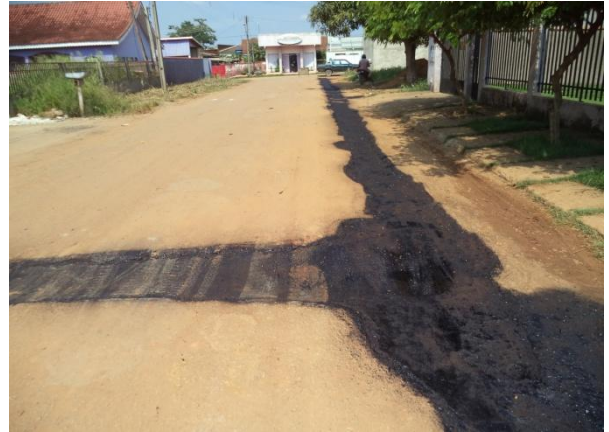
Foto 03: aplicação de CM-30 e assentamento de massa asfáltica na Rua Ceres.
