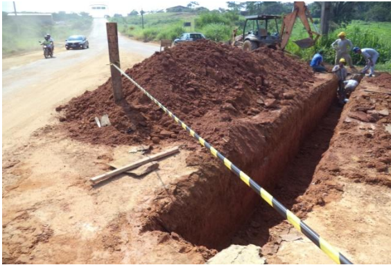
Foto 02: conexão da adutora de 400mm com a adutora de 200mm ambos de FoFo.
