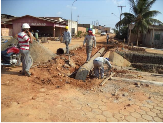
Foto 01: assentamento da adutora de 400mm sobre a passarela.
