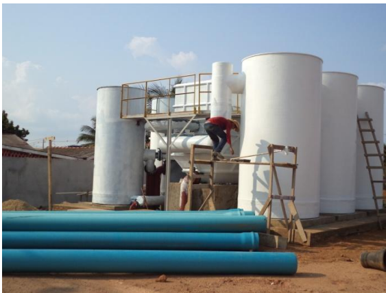
Foto 03: pintura da unidade de tratamento.
