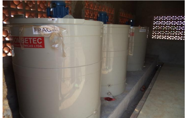
Foto 04: montagem dos tanques de reagentes químicos.
