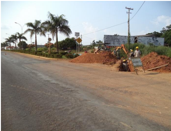
Foto 02: conexão das adutoras de 400mm com a de 200mm ambas de FoFo
