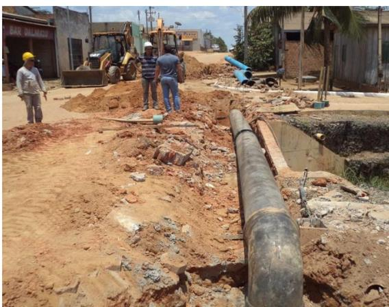
Foto 02: tubulação de ferro fundido sobre a galeria do canal da cidadania
