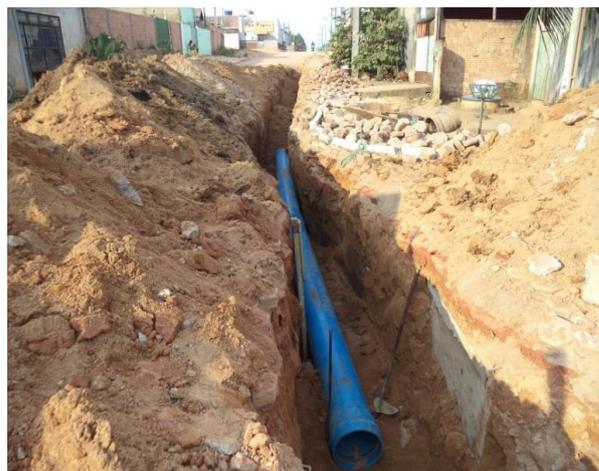
Foto 03: assentamento de adutora de 400mm de FoFo na margem do Canal da cidadania.
