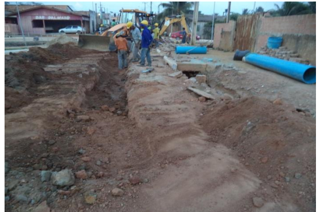
Foto 03: escavação sobre a passarela no canal da cidadania.
