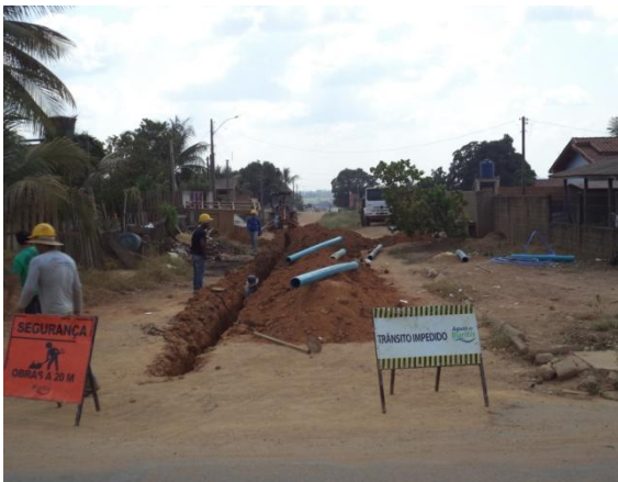
Foto 02: assentamento de tubulação de 150mm de FoFo.
