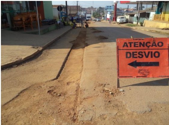
Foto 01: aplicação de CM – 30 e assentamento de massa asfáltica.
