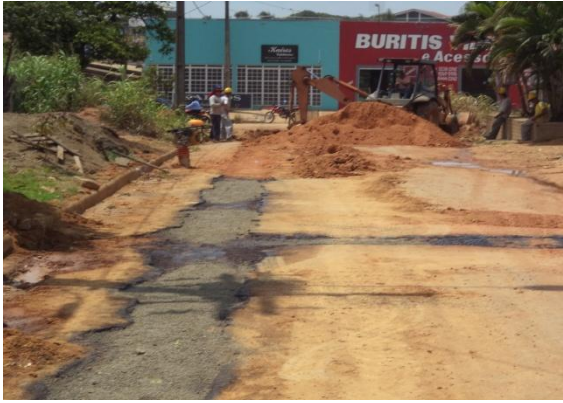
Foto 01: aplicação de CM-30 e aplicação de massa asfáltica.
