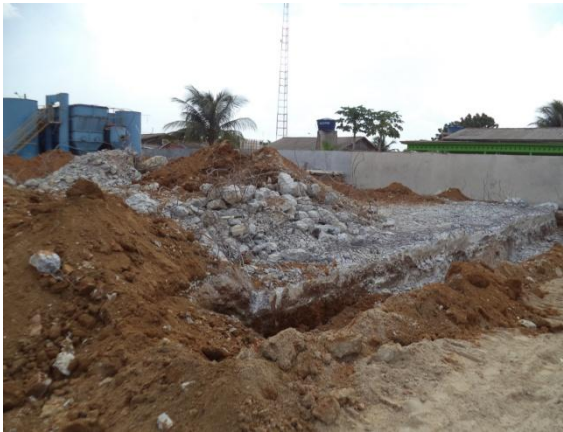
Foto 02: escavação da área de reservação.
