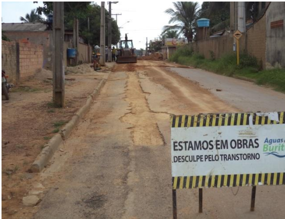
Foto 01: aplicação de CM-30 para imprimação e assentamento asfáltica.
