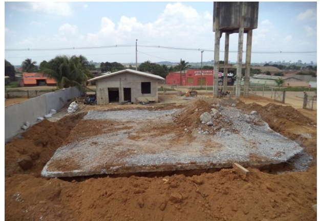
Foto 02: demolição e escavação da área de reservação.
