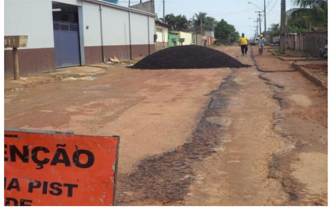
Foto 04: assentamento de massa asfáltica.
