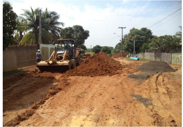
Foto 02 troca de material argiloso para o material de cascalho no trecho.
