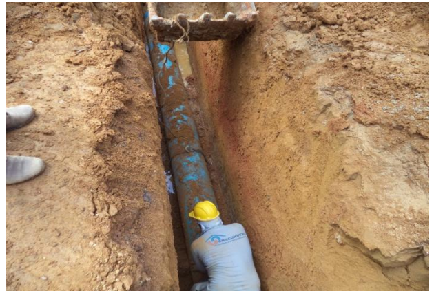
Foto 03: recolocação da adutora de 400mm de FoFo.
