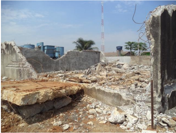
Foto 01: sequenciamento da demolição da área de reservação
