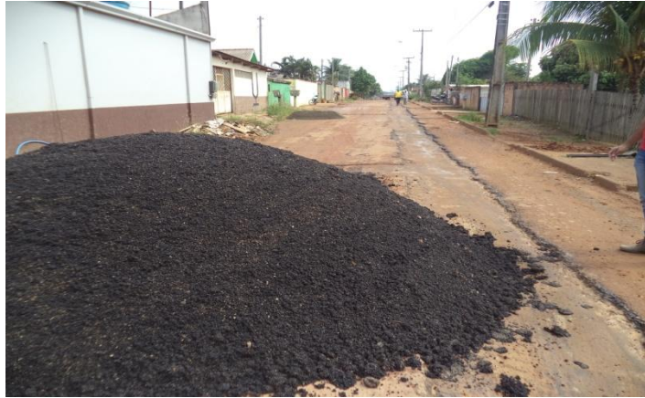
Foto 04: imprimação e assentamento de massa asfáltica.
