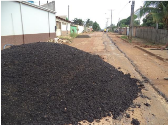
Foto 04: imprimção e assentamento de massa asfáltica.
