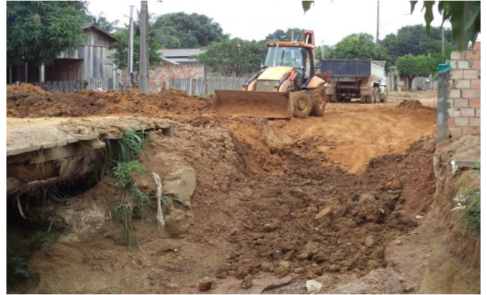
Foto 03: troca do material de aterro por cascalho.
