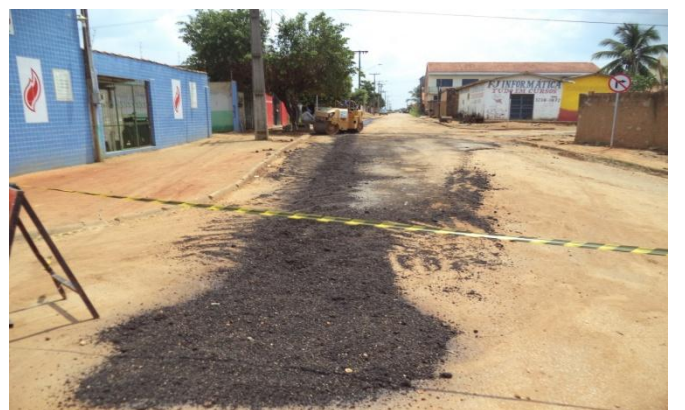
Foto 05: recomposição de pavimento na Rua Ariquemes.
