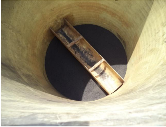
Foto 01: núcleo filtrante da unidade de tratamento com carvão ativado.
