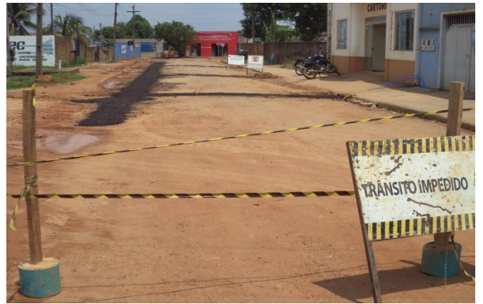
Foto 04: recomposição de pavimento Rua Theo Broma.
