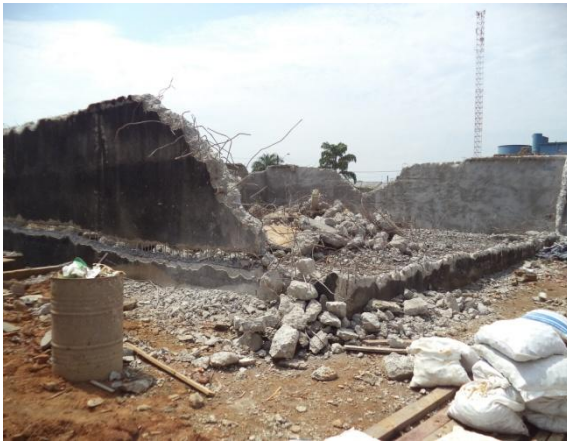
Foto 02: demolição da área de reservação.
