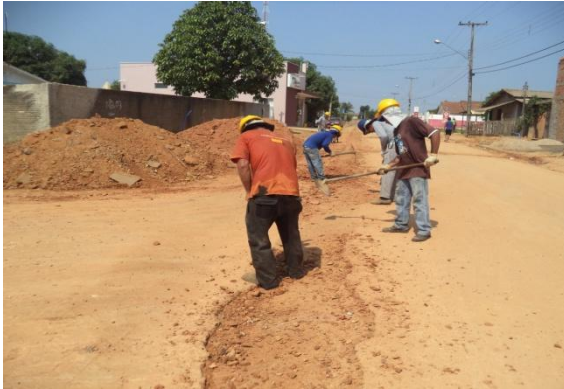
Foto 02: preparação da base para imprimação com CM 30 e assentamento da massa asfáltica.
