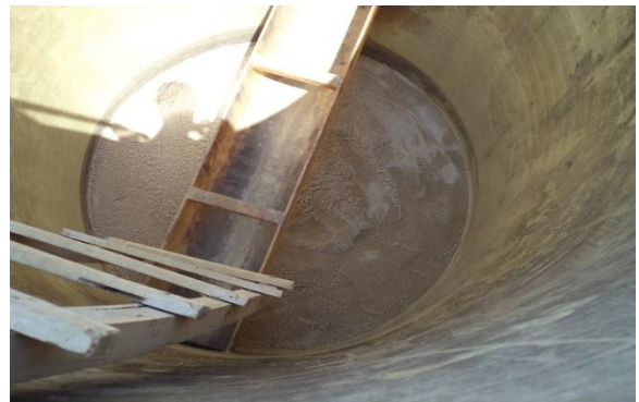
Foto 06: núcleo filtrante com 05 camadas de seixos rolados, 01 camada de areia filtrante e 01camada de carvão ativado.
