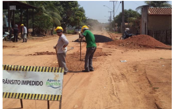
Foto 05: preparação da base para imprimação com CM 30 para assentamento asfáltico.
