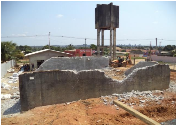
Foto 03: demolição da área de reservação.
