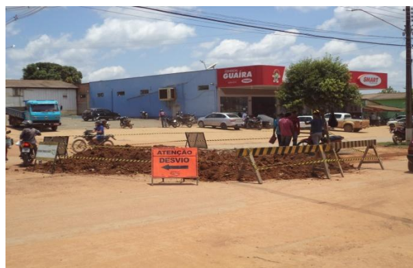
Foto 02: isolamento e sinalização do local.
