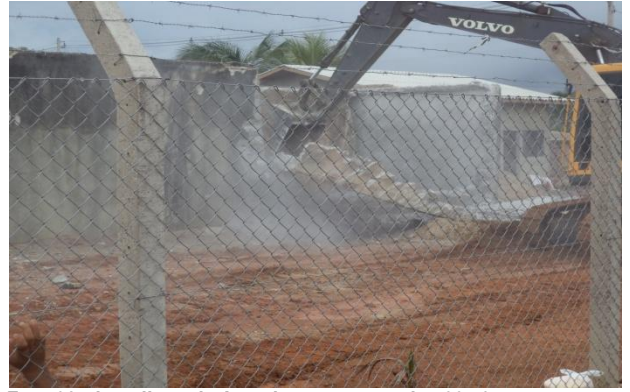
Foto 03: demolição da área de reservação de 500m³ em concreto.
