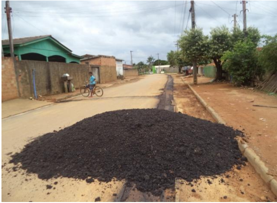
Foto 01: Rua Ariquemes imprimação e assentamento asfáltico.
