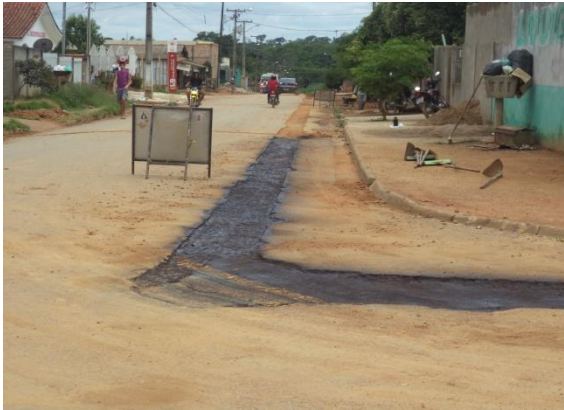
Foto 02: Rua Theo Broma imprimação e assentamento de massa asfáltica.
