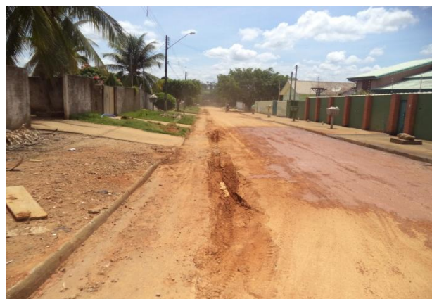
Foto 04: assentamento de rede de distribuição de água de 50mm de PVC – PBA.
