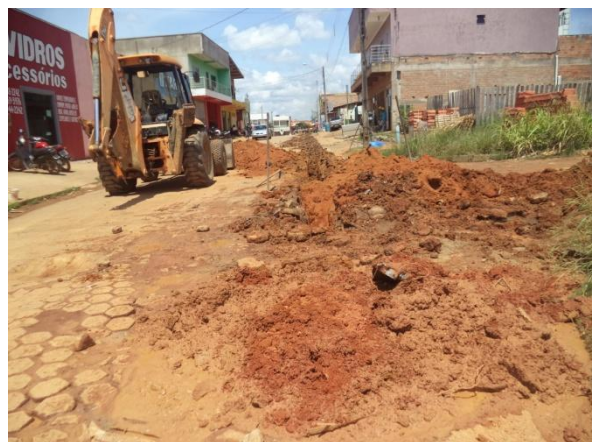
Foto 03: assentamento de rede de distribuição de água Com tubulações de 50mm de PVC – PBA.
