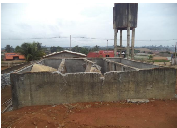
Foto 02: demolição da área de reservação.
