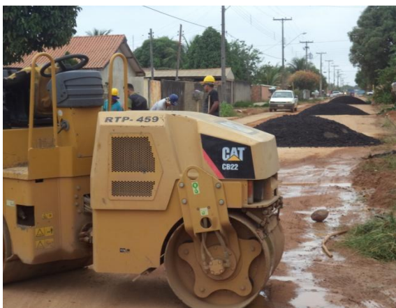
Foto 01: assentamento de massa asfáltica para recomposição de pavimento.
