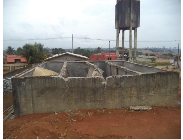
Foto 02: demolição da área de reservação.
