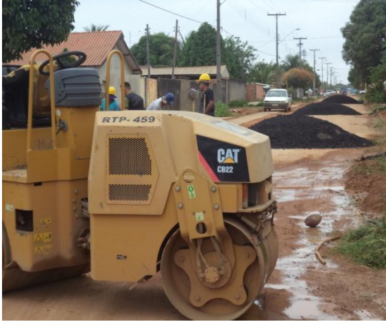
Foto 01: assentamento de massa asfáltica para recomposição de pavimento.
