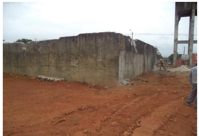
Foto 05: ETA - demolição da área de reservação.
