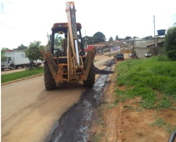
Foto 02: aplicação de ICM – 30 e assentamento de massa Asfáltica.
