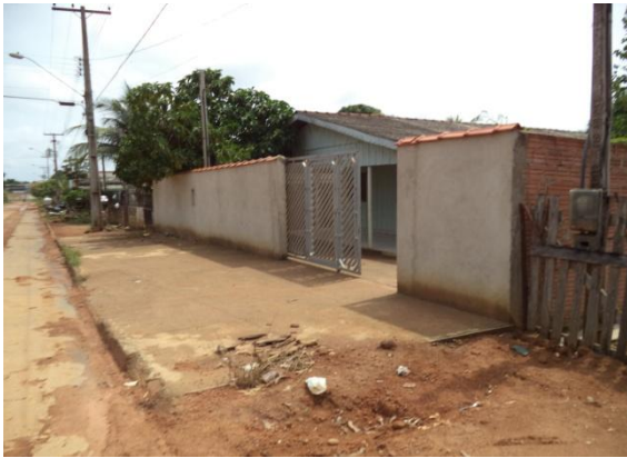
Foto 01: vistoria in loco no local do ponto de distribuição de Água danificado.
