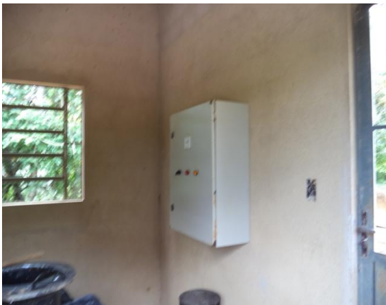
Foto 03: montagem do painel na captação.
