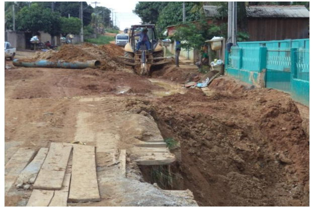
Foto 04: finalização do envelopamento da adutora no igarapé do setor 02.
