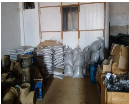
Foto 04: sacos de massa asfáltica acondicionados em contato direto com o solo se estrado – inconformidade.
