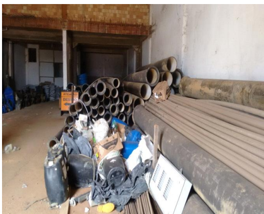
Foto 03: tubulações amontoados de forma irregular – inconformidade.
