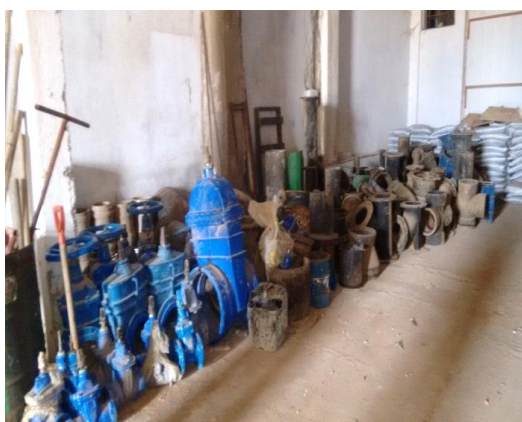
Foto 06: registros,redutores e válvulas armazenados em contato direto com o solo podendo ocasionar avarias – inconformidades.
