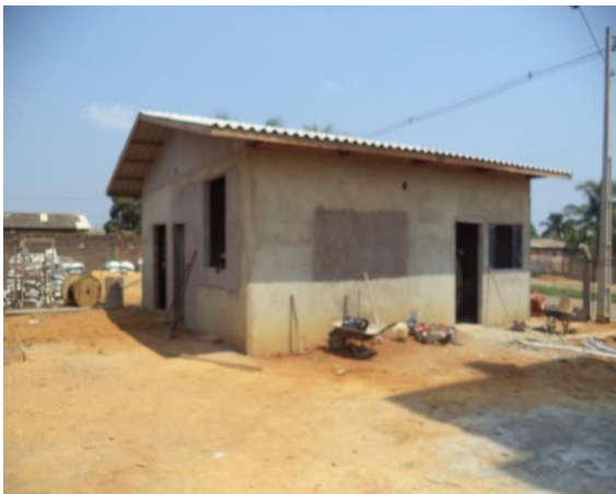
Foto 03: ETA - recuperação da casa de química.
