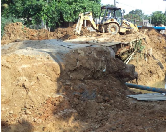
Foto 01: fatores naturais impedem o andamento das atividades no assentamento de adutora.
