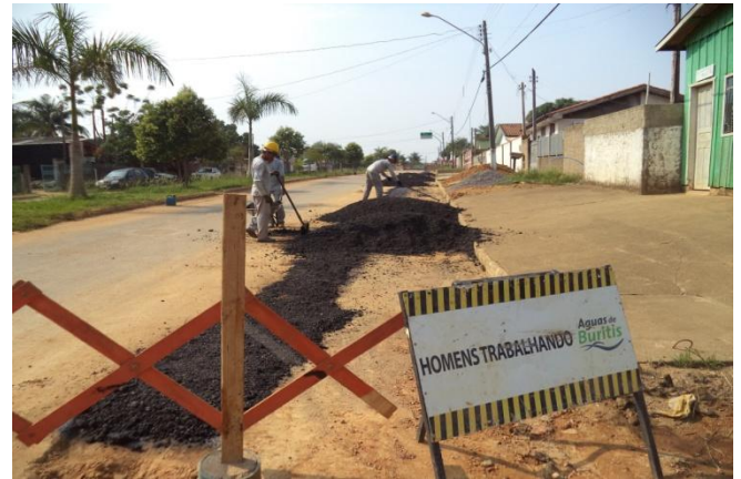
Foto 04: assentamento de massa asfáltica para na recomposição de pavimento.
