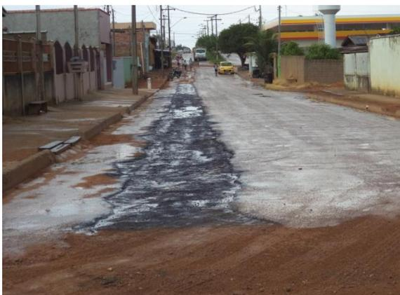
**Foto 01: aplicação de ICM – 30 para permeabilização para a recomposição asfáltica.**
