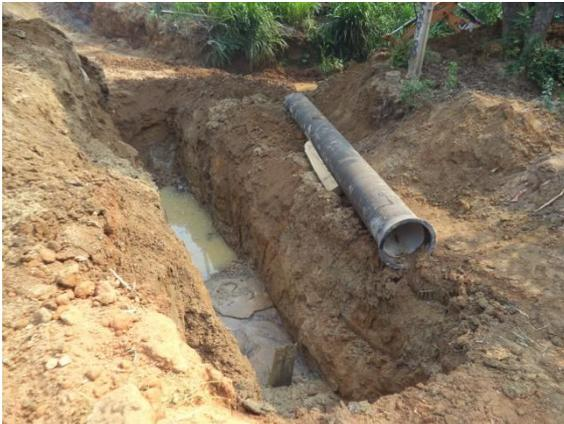
Foto 02: assentamento da adutora de 400mm de ferro fundido no Igarapé do setor 02.
