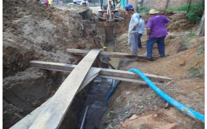
Foto 03: realização do envelopamento em concreto na tubulação de ferro fundido no leito da igarapé no setor 02.
