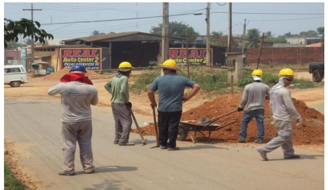
Foto 04: preparação da base para a compactação com material de base.
