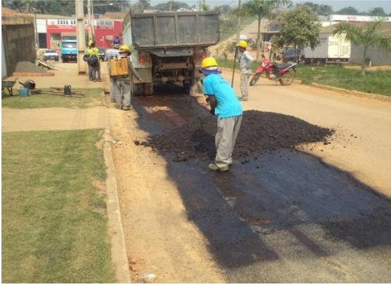
Foto 01: aplicação de ICM – 30 e assentamento de massa asfáltica.
