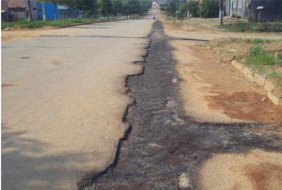
Foto 01: aplicação de ICM – 30 para assentamento asfáltico.
