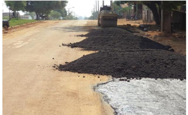
Foto 05: aplicação de ICM – 30 e assentamento asfáltico.
