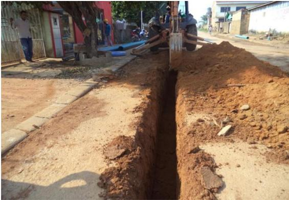
Foto 03: assentamento da rede de distribuição de água de 200mm de FoFo e de 50mm de P
