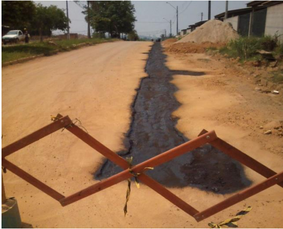
Foto 01: aplicação de ICM - 30 para impermeabilização da base.
