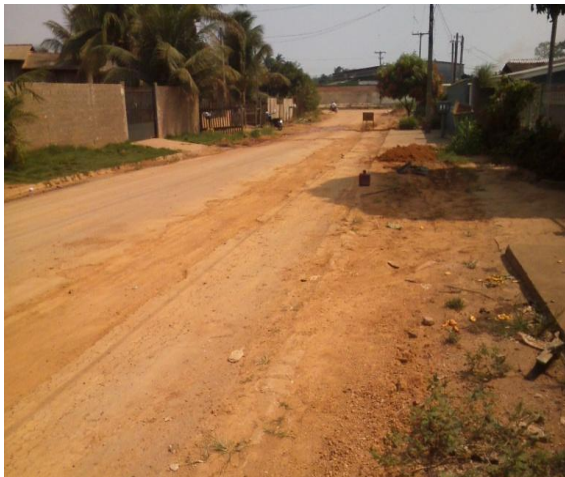
Foto 01: preparação de base para recomposição de pavimento.
