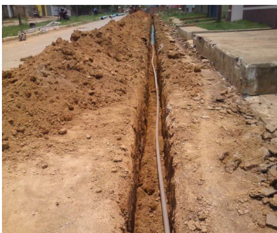
Foto 02: assentamento de rede para distribuição de água com tubulações de 200mm de FoFo e de 50mm de PVC – PBA.
