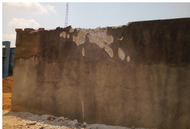
Foto 03: demolição da caixa de reservação de 500m 3 .
