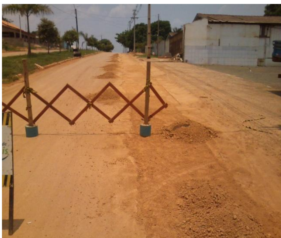
Foto 01: preparação com o material de base para recomposição de pavimento
