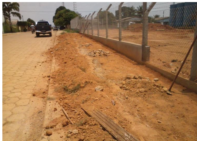
Foto 04: recuperação da calçada na estação.
