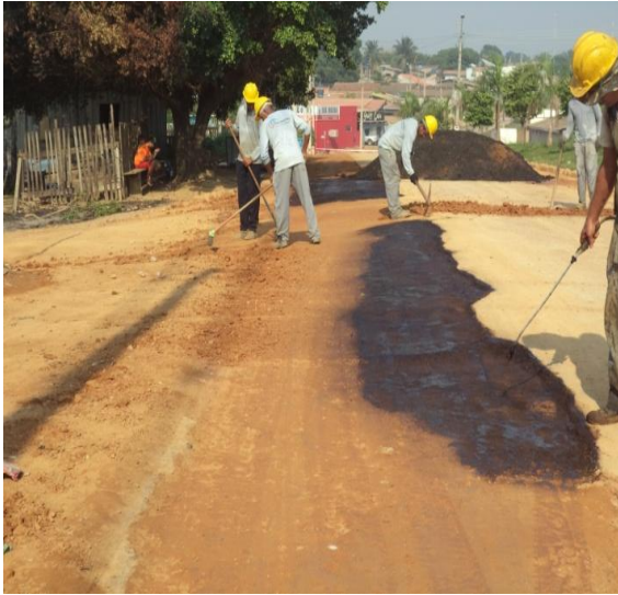
Foto 01: aplicação de ICM – 30 e assentamento asfáltico para recomposição de pavimento.
