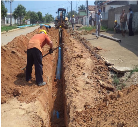
Foto 02: assentamento de rede de distribuição de água com tubulações de 200mm de FoFo e de 50mm de PVC – PBA.
