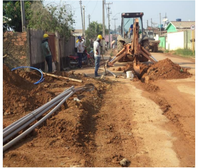
Foto 03: assentamento de rede de distribuição de água com Tubulações de 50mm de PVC – PBA
