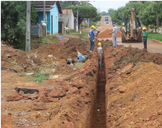
Foto 02: assentamento tubulação 200mm de FoFo e 50mm de PVC – PBA, uma descarga, 2(T)s, 1RD200x150 e 1 curva de 90º ambos de ferro Fundido.
