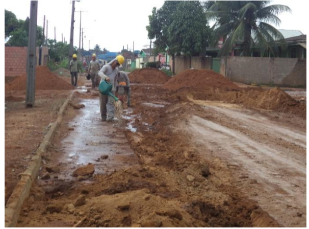
Foto 03: preparação da base com material para compactação.
