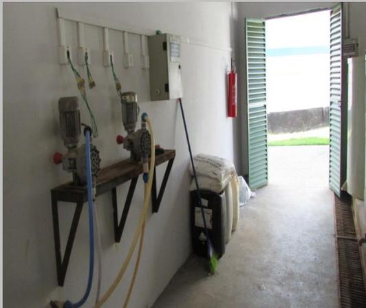
Foto 04: compartimento de dosadores devidamente funcionando, com extintor ao fundo – conformidade.
