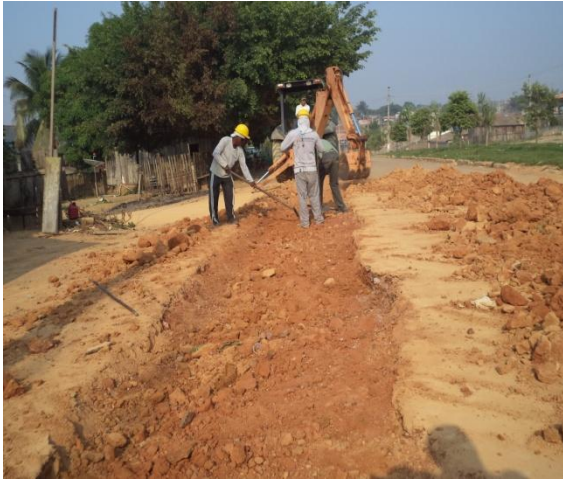
Foto 01: preparação da base para a recomposição de pavimentos
