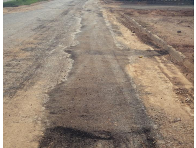
Foto 02: assentamento de massa asfáltica já pavimentada.
