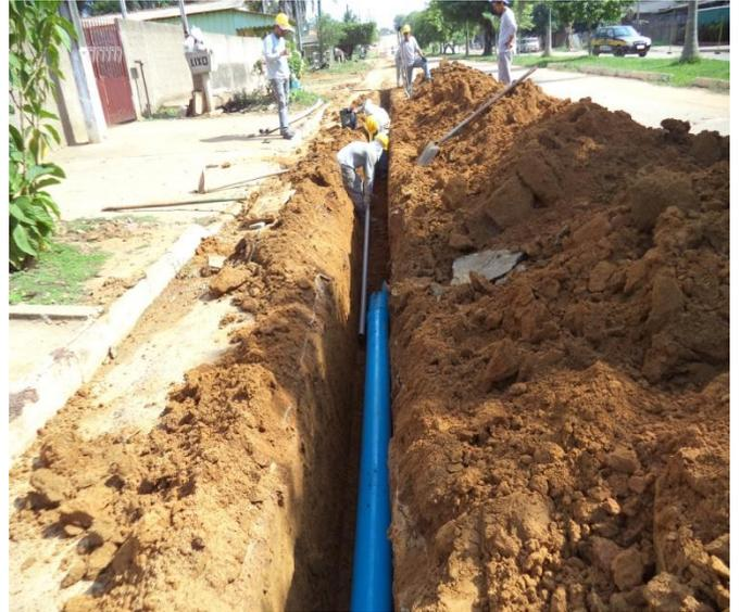
Foto 02: assentamento de rede de distribuição de água com tubulações
