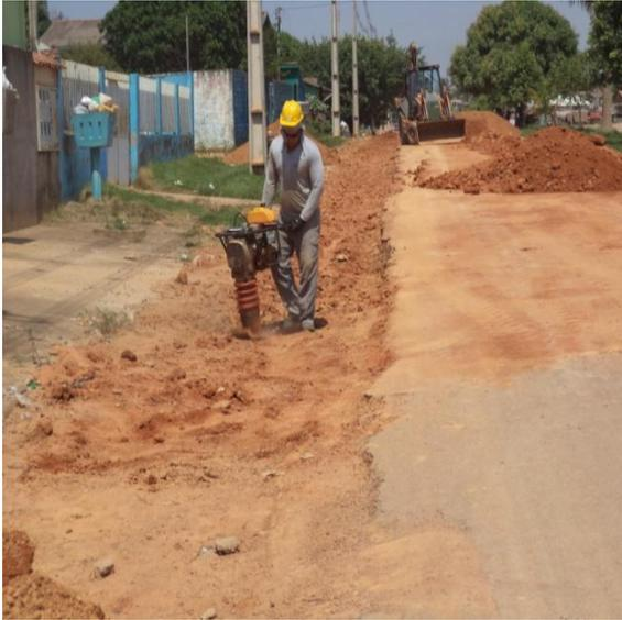
Foto 01: preparação de base para recomposição de pavimento.
