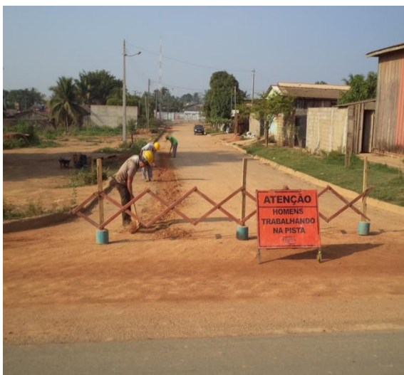
Foto 01: Rua Minas Gerais, preparação da base para recomposição de pavimento.
