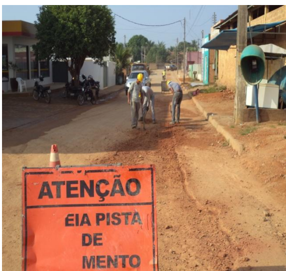
Foto 02: Rua Seringueiras preparação da base para recomposição de pavimento.
