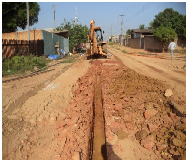
Foto 03: escavação e assentamento de tubulação de 50mm PVC- PBA.
