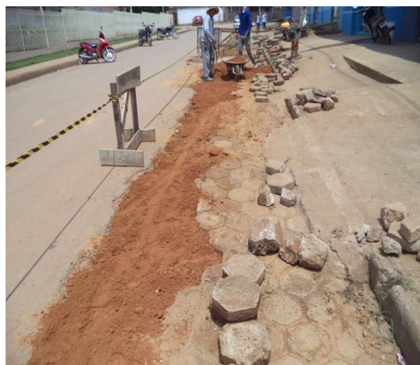
Foto 04: Rua Rio Madeira preparação de base para recomposição dos bloquetes.
