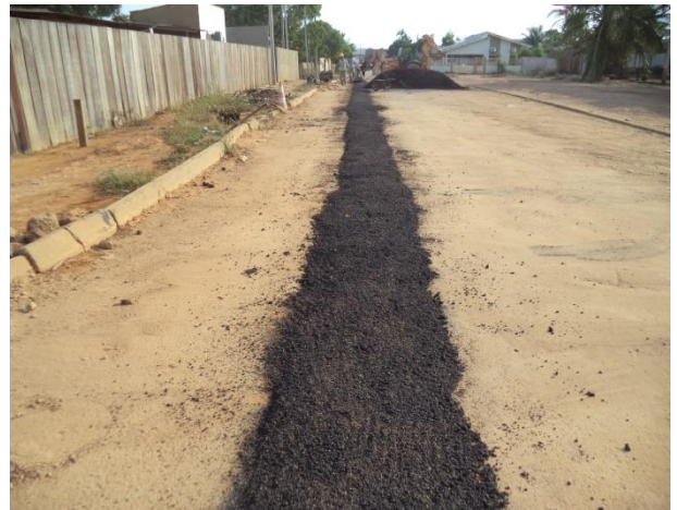
Foto 04: aplicação de ICM – 30 e assentamento de massa asfáltica.
