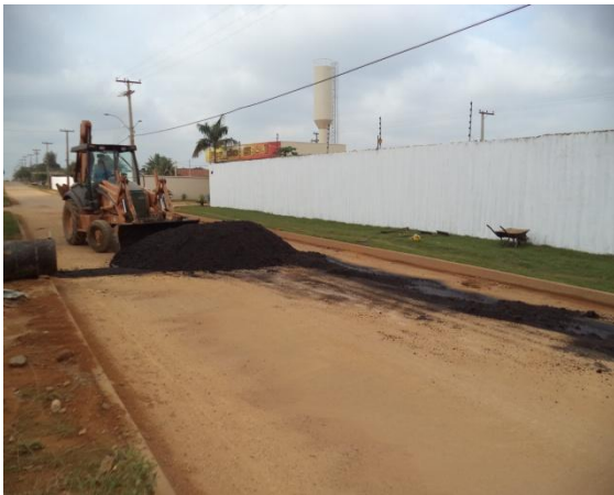
Foto 02: aplicação de ICM – 30 e assentamento asfáltico.
