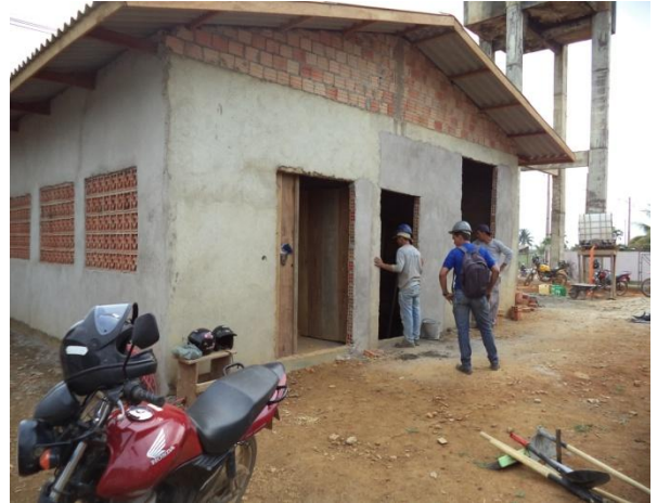
Foto 03: casa de química.
