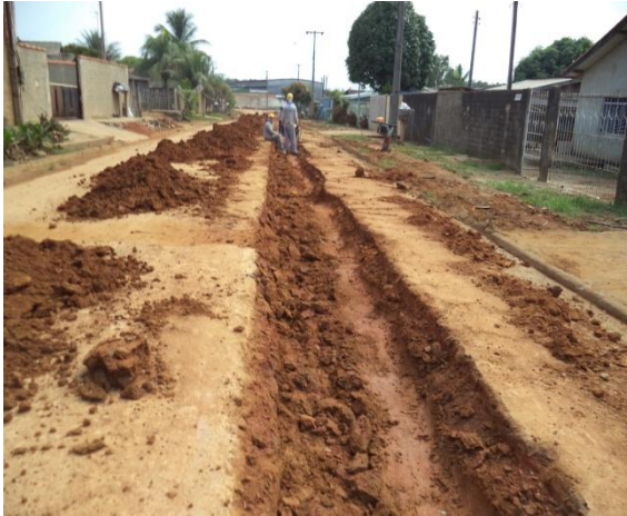
Foto 01: atividades de compactação com material de base.
