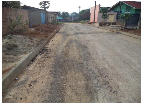
Foto 03: recomposição de pavimentos já executada na Rua Pequena Vanessa.
