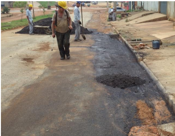
Foto 02: assentamento de massa asfáltica para recomposição de pavimentos.
