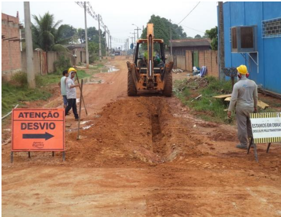
Foto 01: assentamento de rede de 50mm de PVC – PBA.
