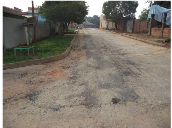
Foto 04: recomposição de pavimento já executada, na Rua Niterói.
