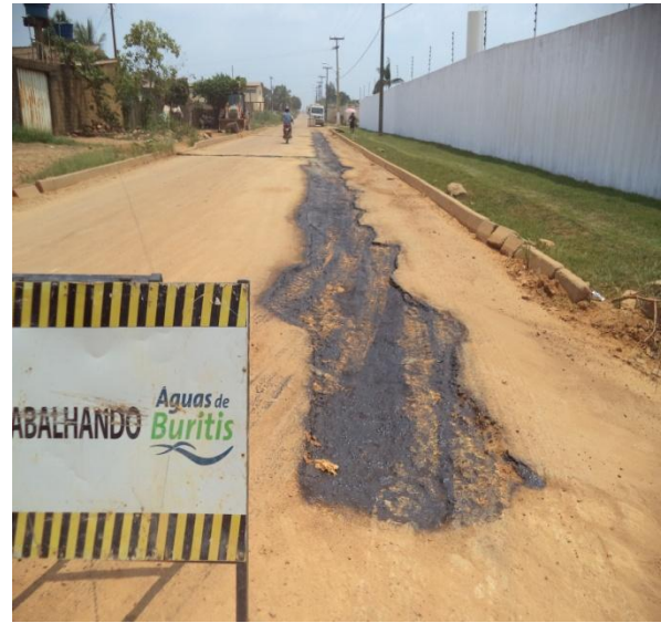
Foto 02: aplicação de ICM – 30, e em sequencia assentamento de massa asfáltica.
