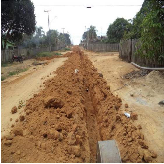
Foto 01: assentamento de rede de distribuição de 50mm de PVC – PBA.
