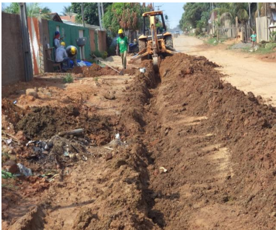
Foto 02: assentamento de rede de distribuição de 50mm de PVC - PBA.
