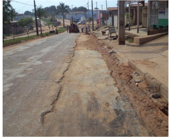
Foto 03: preparação de base para recomposição de pavimento.
