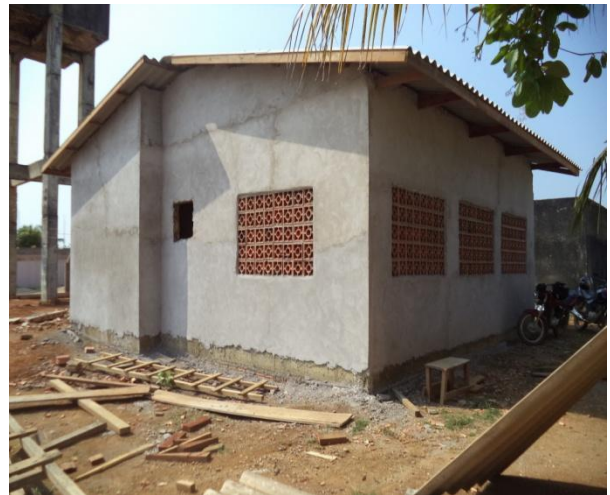
Foto 04: ETA – casa de química.
