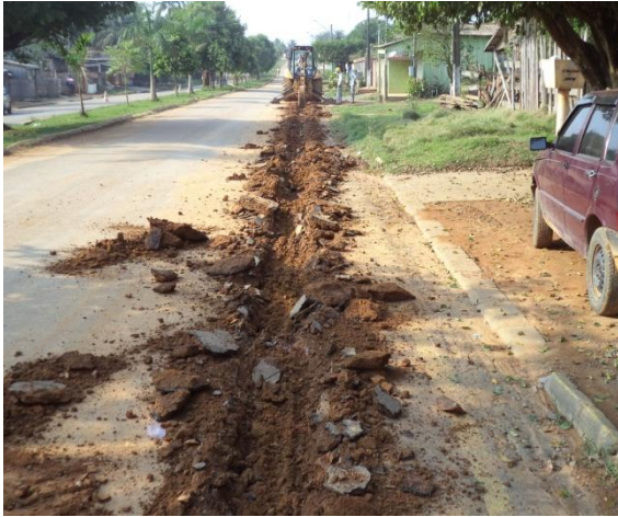
Foto 01: assentamento da rede de distribuição de água de 200mm de FoFo e de 50mm de PVC – PBA.
