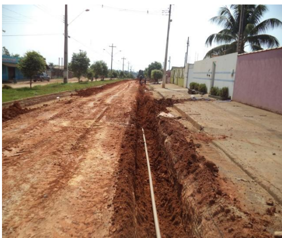
Foto 02: assentamento de rede de 50mm de PVC – PBA.
