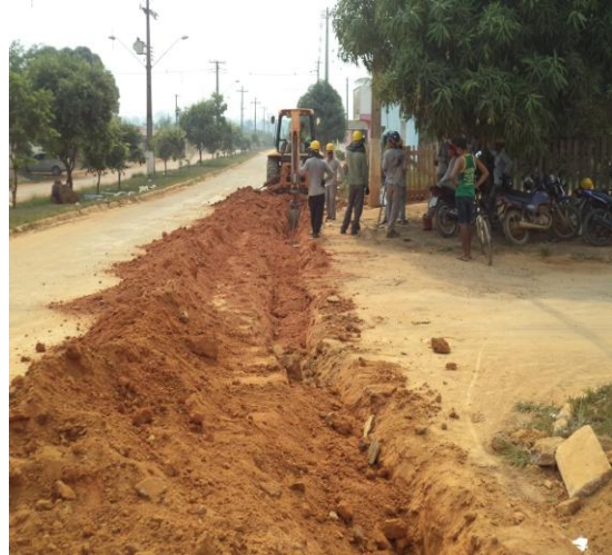
foto 02: assentamento de rede de 50mm de PVC – PBA.
