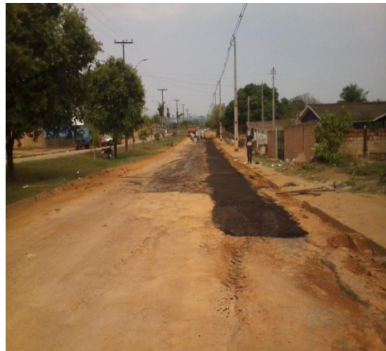
Foto 03: assentamento da massa asfáltica na recomposição de pavimento.
