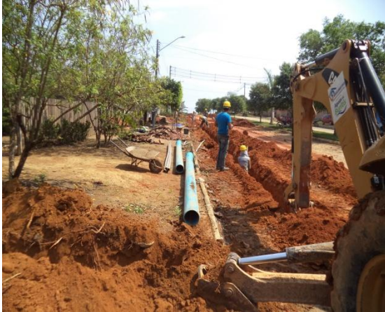
Foto 01: assentamento de rede de distribuição de água, com tubos de 200mm de FoFo e de 5
