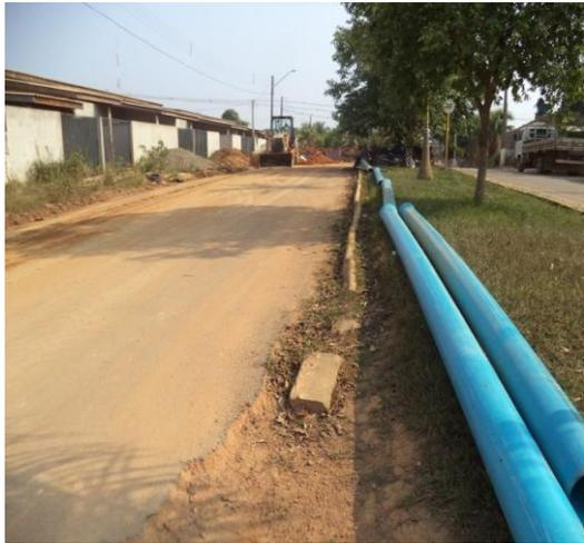
**FOTO 01:** assentamento de rede de 200 e 50mm para distribuição de água.
