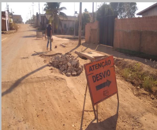
Foto 01: momento da recuperação do pavimento do bloquetamento.
