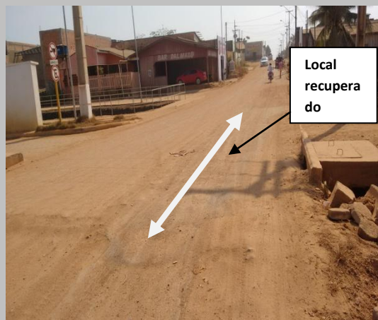
Foto 02: pavimento do bloquetamento recuperado.
